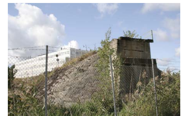
Befintlig situation: Spår av gammal brokonstruktion som gått över Bällstaån
