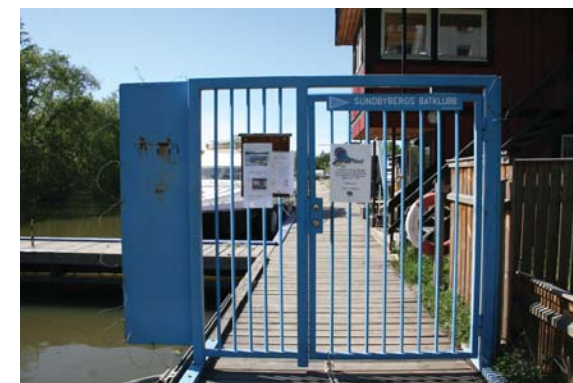
Befintlig situation: Grinden är ofta låst och bryter promenadstråket
