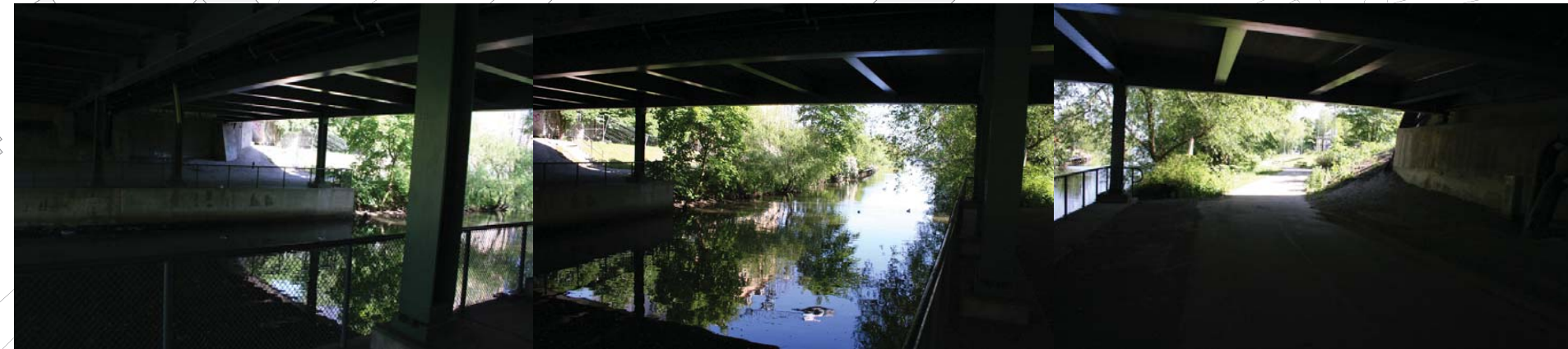
Befintlig situation: Det mörka rummet under Bällstabron skapar en otrygg plats
