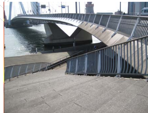
Referensbild: Generös koppling mellan bronivå och strandnivå. Erasmusbron, Rotterdam av Ben van Berkel
