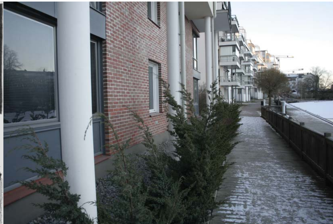
Vid Ågatan kan man se en konflikt mellan det privata och det offentliga som bland annat visar sig i att man skapat rabatter mellan den smala gångvägen och lägenheterna i bottenvåningen för att hindra insyn. Ett lågt staket, kanske uppsatt för barns säkerhet, skapar ytterligare otydlighet om vad som är offentligt eller ej.
