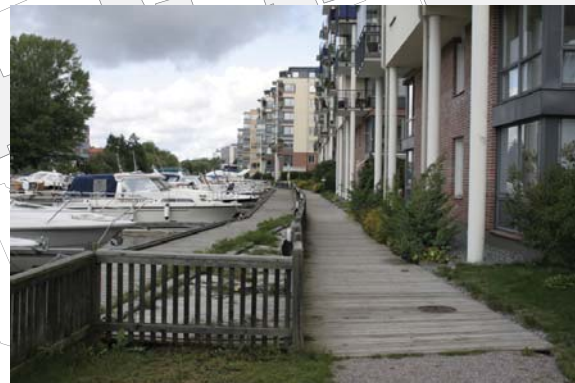
Befintlig situation: Splittrat intryck med tre olika bryggytor och staket som delar av. Promenadvägens material växlar fram och tillbaka mellan grus och brygga
